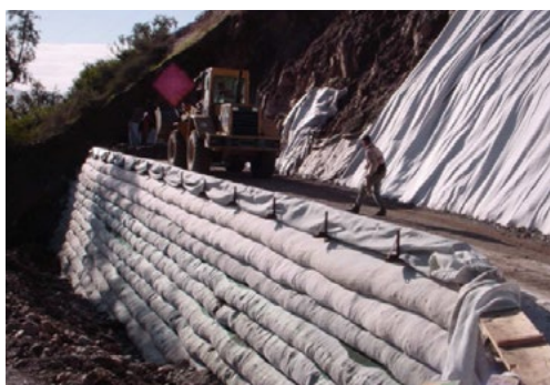
Soutènement en remblai renforcé
