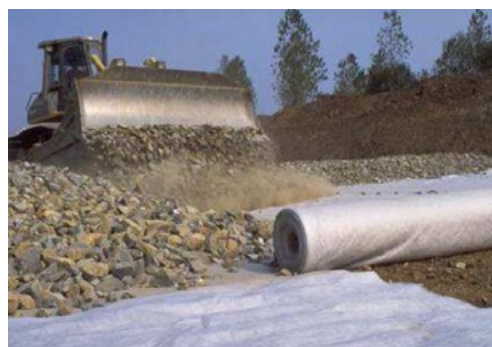
Géotextile non tissé en séparation
