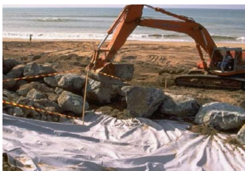
Filtration et séparation (enrochements)
