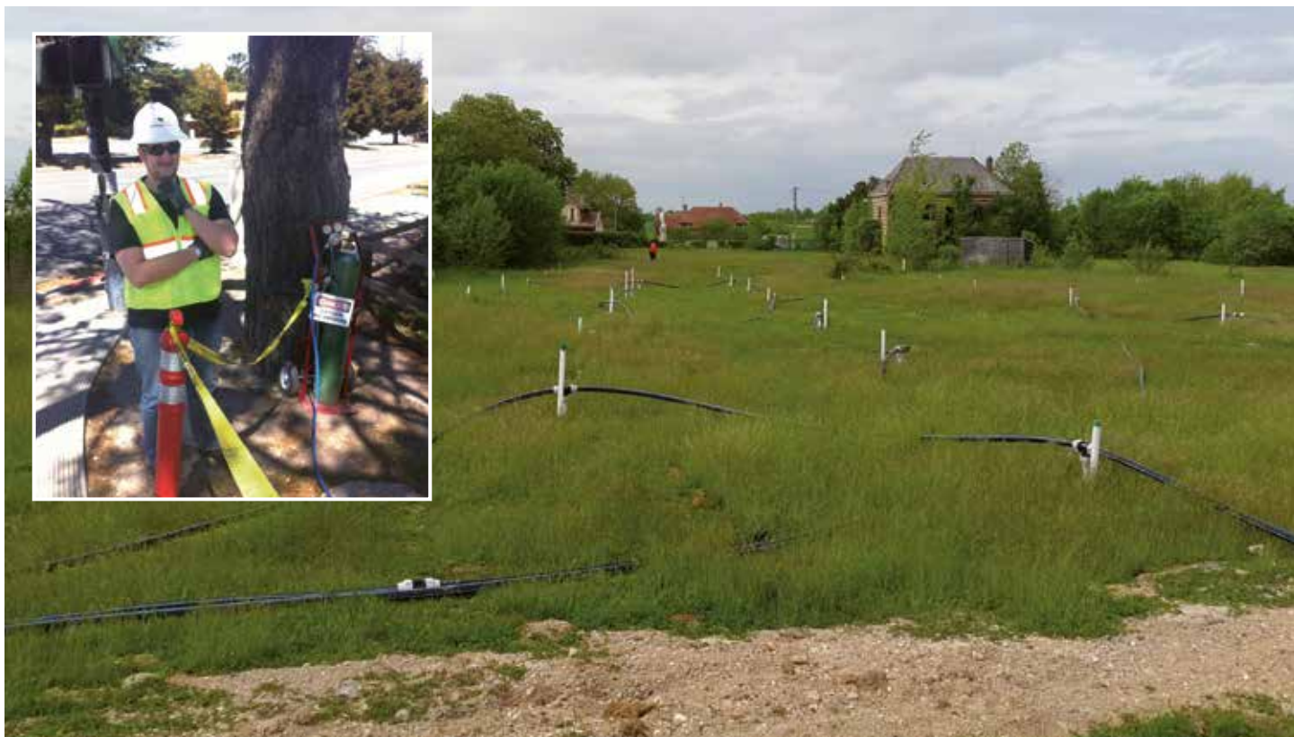
Dépollution par venting.
