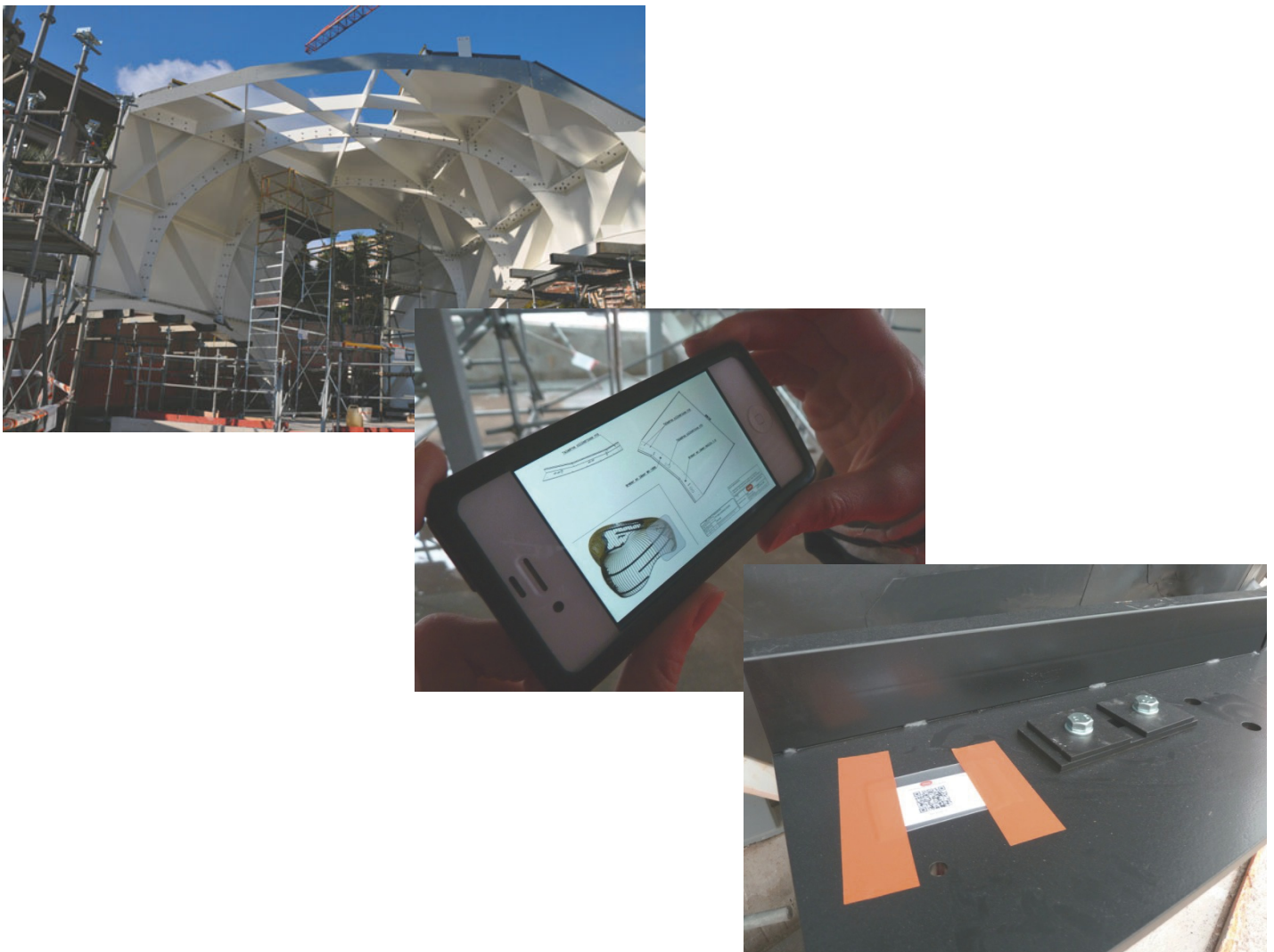
Figure 61. Utilisation de la maquette numérique pour accompagner la mise en œuvre d'éléments préfabriqués sur le chantier (© Setec Bâtiment).
