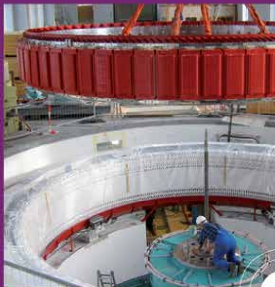
Rénovation de la centrale hydroélectrique de Chancy-Pougny (Suisse) - montage du nouveau rotor
