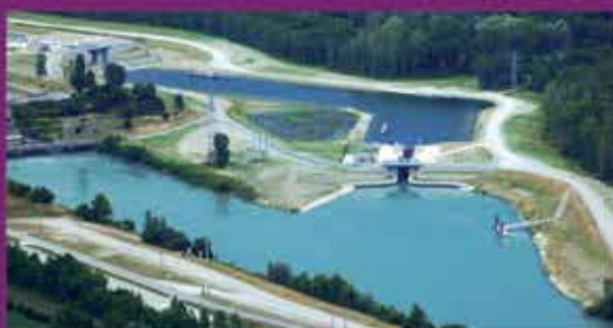
Vue aérienne des nouvelles écluses et de la centrale hydroélectrique de Chautagne
