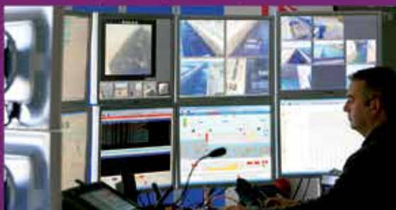
Nouveau Centre de Gestion de la Navigation à Châteauneuf-du-Rhône
