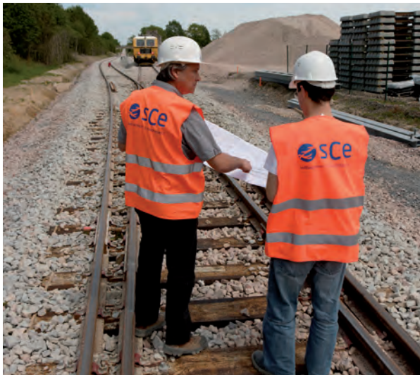
Chantier du tram-train.
