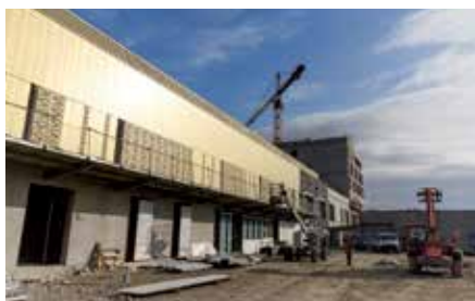
Le chantier Rhéna en novembre 2015
