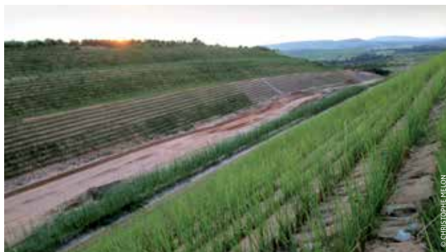
Le chantier Vétiver au Congo
