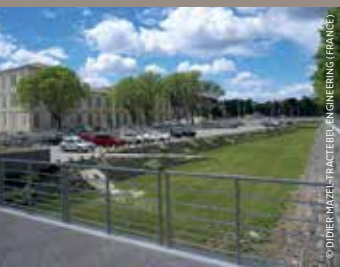
Nîmes - Les bassins « Hoche » en bordure de l'Université et des nouveaux îlots constructibles (1 re tranche de travaux)
