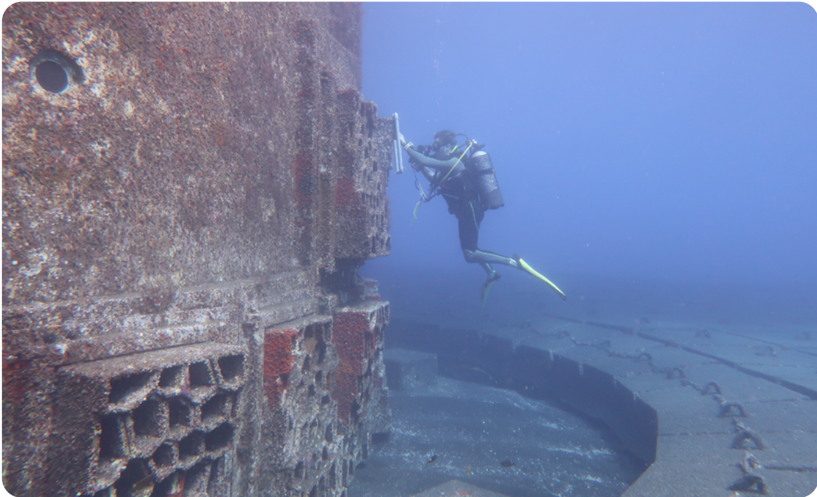
Dans le cadre du projet de Nouvelle Route du Littoral, les aménagements prévus ont proposé une écoconception au niveau de certaines piles du viaduc. Cela a notamment consisté en l'ajout de modules éco-conçus, créant des habitats favorables à la vie sous-marine. En plus des tapis anti-affouillement disposés au pied des piles, cela permet le développement de nombreuses espèces, dans un environnement initialement plus pauvre (milieu sédimentaire). Les différents suivis réalisés ont montré un développement marqué de la biodiversité marine. MOA : Région Réunion Consortium pour la construction du viaduc : Demathieu Bard Construction / Bouygues TP / Dodin Campeno Bernard / Vinci Construction MOE : Egis / AMOE : Biotope (Assistant à Maître d'Ouvrage Environnemental)
