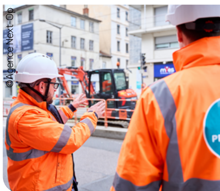
Présents sur chantier
