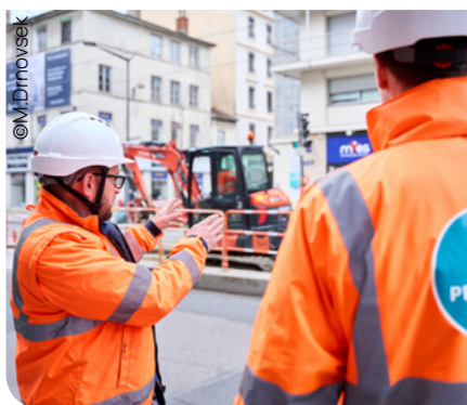
Présents sur chantier
