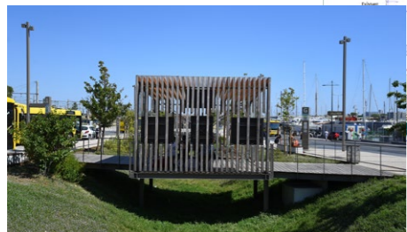
Aire d'attente pour les voyageurs dans le pôle bus du PEM
