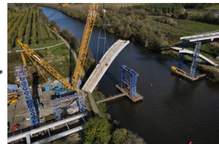
Pose du tronçon central de l'arc
