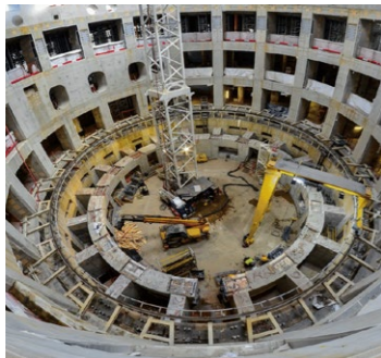
Septembre 2017 - fin des travaux du génie civil dans le bâtiment du réacteur nucléaire
